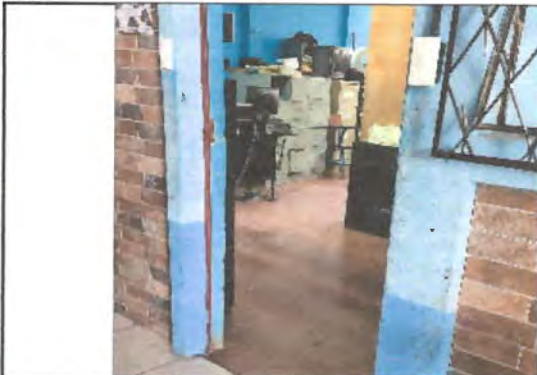
Foto 4: Colocación de Piso en el área de Dirección
