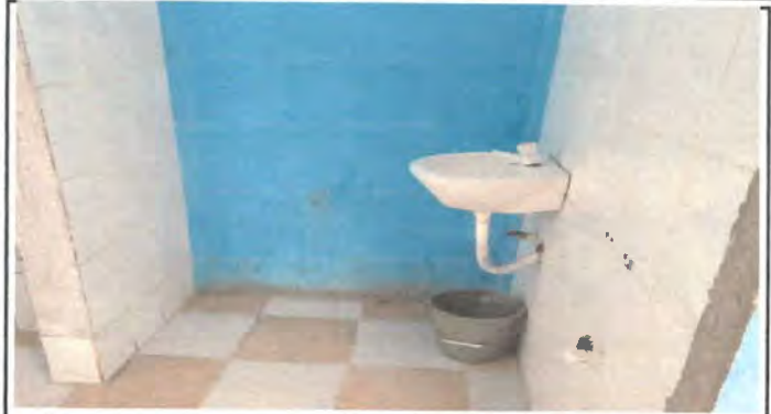
Foto 2: Instalación de lavamanos
