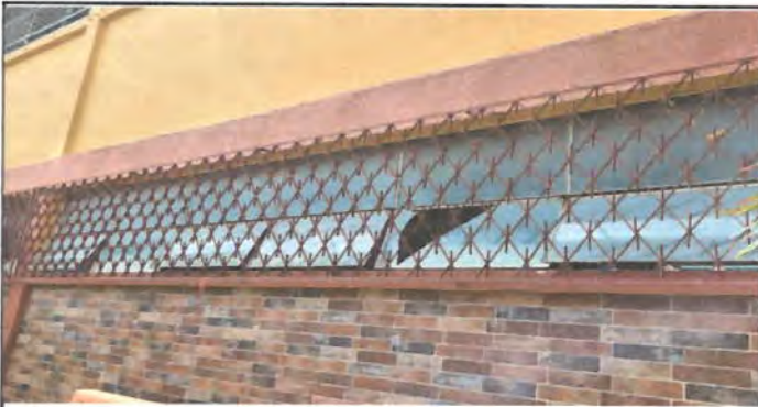
Foto 3: Desmontado y colocación de Ventanas de PVC
