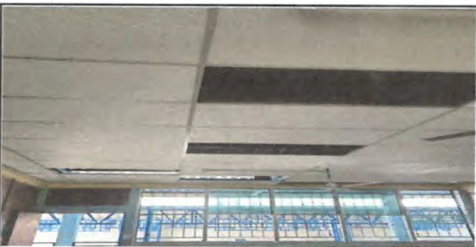
Foto 5: Desmontado y Colocación de cielo Falso
